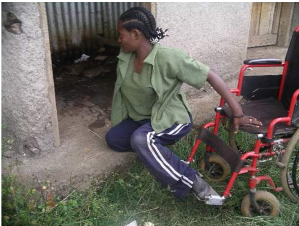
Figure 1.5 L'accès de cette jeune femme à cette toilette est difficile en raison des marches, de l'entrée étroite, de l'absence de rampes à l'intérieur et de la saleté du sol.
